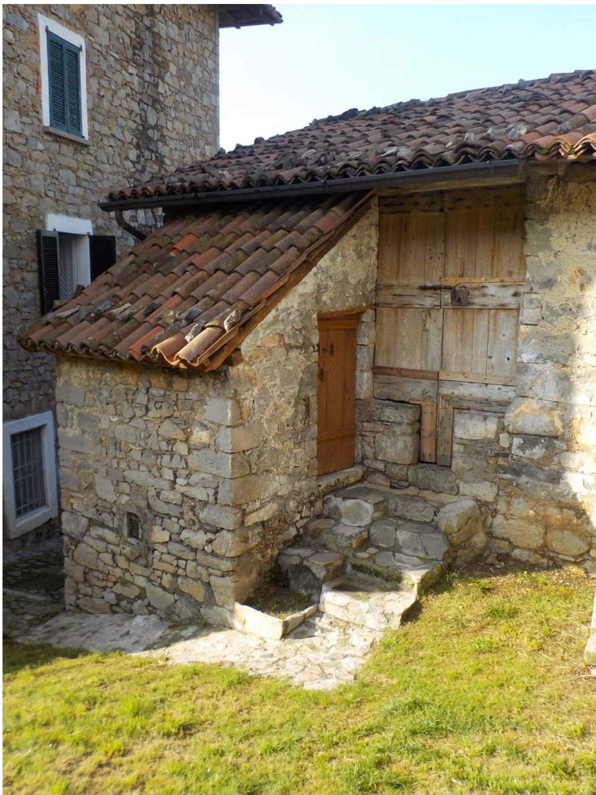
Grange à l'ancienne. L'écurie est dessous. On accède à ce local par une porte unique, avec dans le bas le passage pour les jambes, et dans le haut celui pour les hottes, soit gabie.
