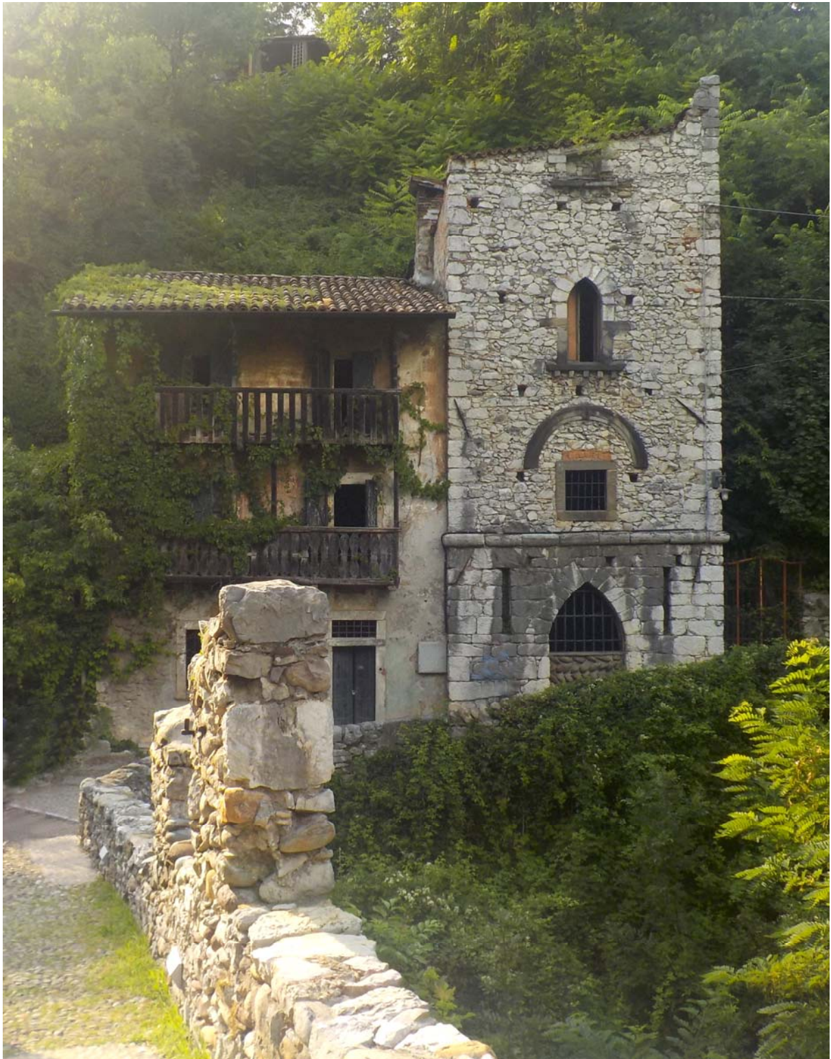
Le poste de douane « chemin pédestre » de Clanezzo. L'endroit garde beaucoup de charme.
